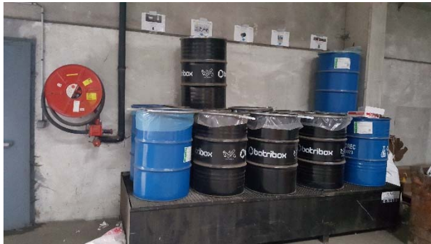
Photo 4. Fûts de regroupement des piles et accumulateurs dans le hangar « Stockage » (Source : audicé environnement )
