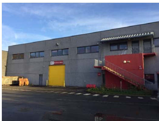
Photo 10. Bâtiment administratif, ateliers et vestiaires
